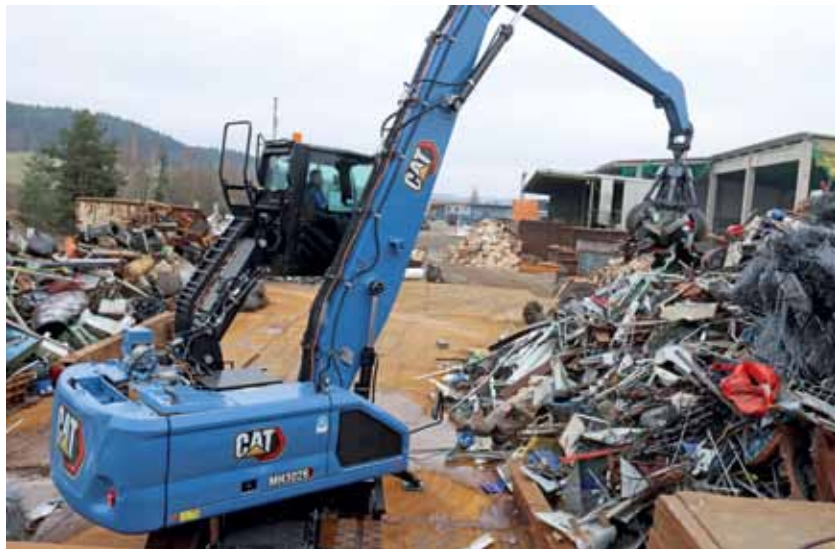
Mit seinem Greifer packt der Bagger die schweren Metalle.
